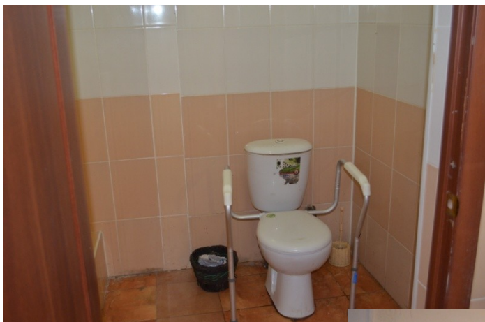
Оборудование санитарных узлов
